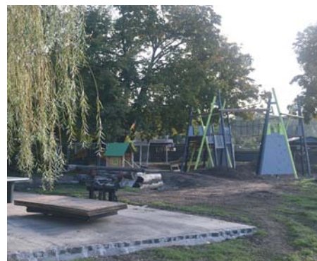
Ein neuer Spielplatz entsteht.
